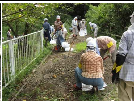
9/6 拠点地へ上る道の補 修作業
