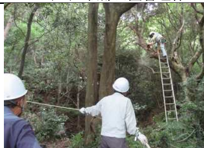
プール跡地整備 6/26
